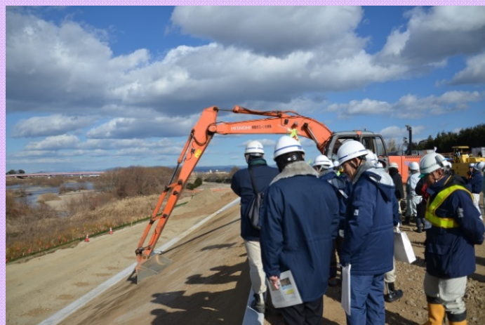
2/2 ICT活用工事現場見学会 (矢作川西浅井築堤護岸工事・西尾市)②
