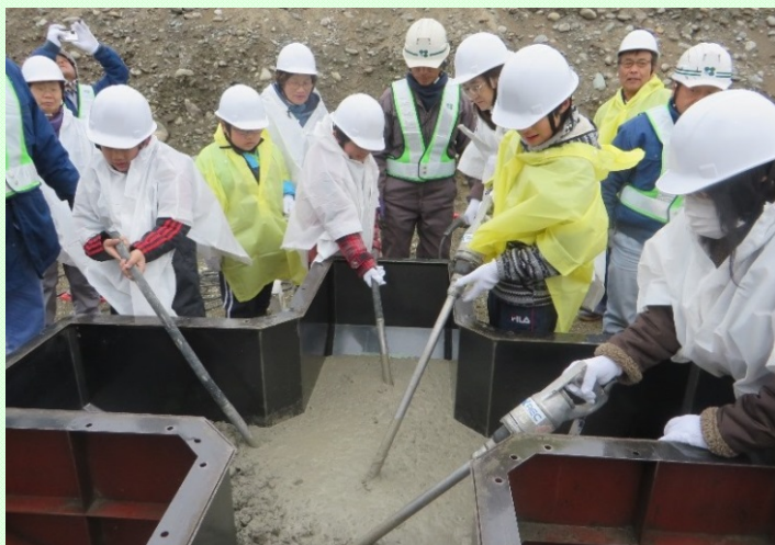
2/18 天竜川総合学習館「かわらんべ講座」で 河川工事現場見学会を実施②
