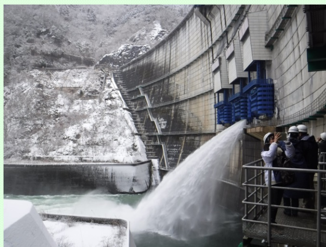
2/11 期間限定！矢作ダム放流見学会 (愛知県豊田市・岐阜県恵那市)
