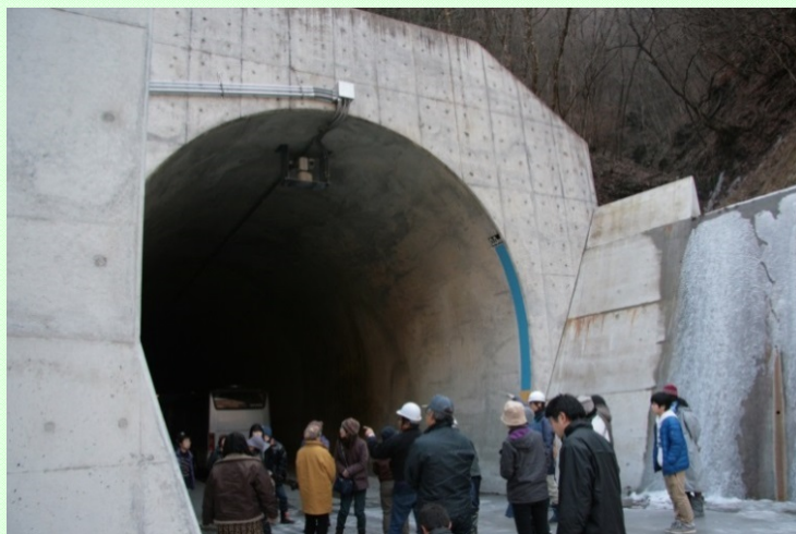
2/18 天竜川総合学習館「かわらんべ講座」の参加者30名が ダム堤体、土砂バイパストンネル吐口～呑口を見学 (小渋ダム:長野県上伊那郡中川村)
