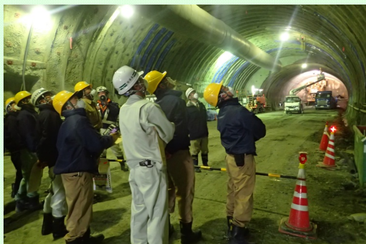
2/27 静岡県建設学院の皆さんが現場見学② ～北勢バイパス坂部トンネル(仮)工事～ トンネル掘削現場内において施工状況見学
